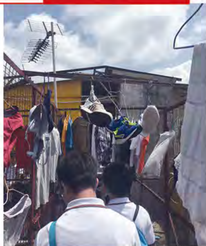
土瓜灣區天台屋環境惡劣。 Poor living conditions of rooftop flats in To Kwa Wan.
